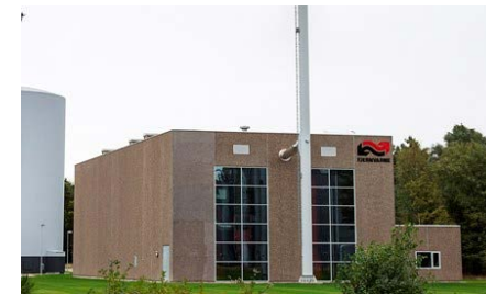
Brande varmeværk (riste forbrænding)
